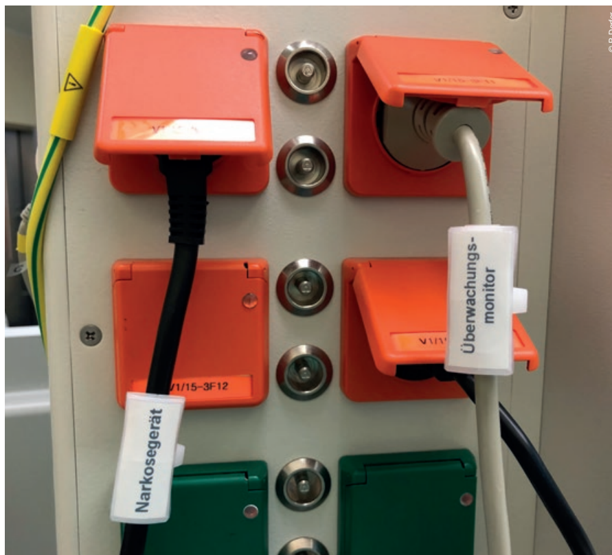
Ein Beispiel für eine Maßnahme infolge einer CIRPS-Meldung: „Steckernahe“ Beschriftung der Kabel im OP, damit das „richtige“ Kabel abgezogen wird, wenn alles mit OP-Tüchern abgedeckt ist.
