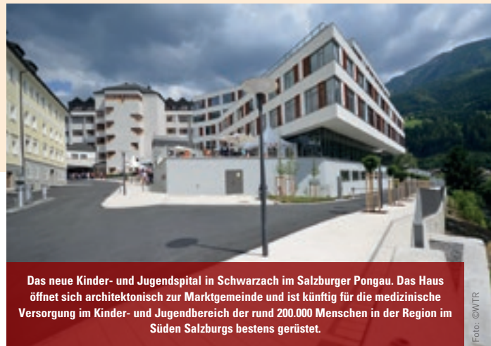
Das neue Kinder- und Jugendspital in Schwarzach im Salzburger Pongau. Das Haus öffnet sich architektonisch zur Marktgemeinde und ist künftig für die medizinische Versorgung im Kinder- und Jugendbereich der rund 200.000 Menschen in der Region im Süden Salzburgs bestens gerüstet.
